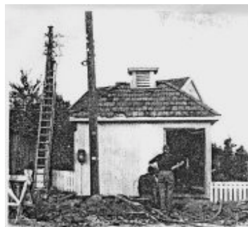
Gammel kiosk (trafo) på Apenes 1962. Apenes fikk kiosk 1919 Kilde: Nettstasjonsarkivet, Horten elektrisitetsverk
